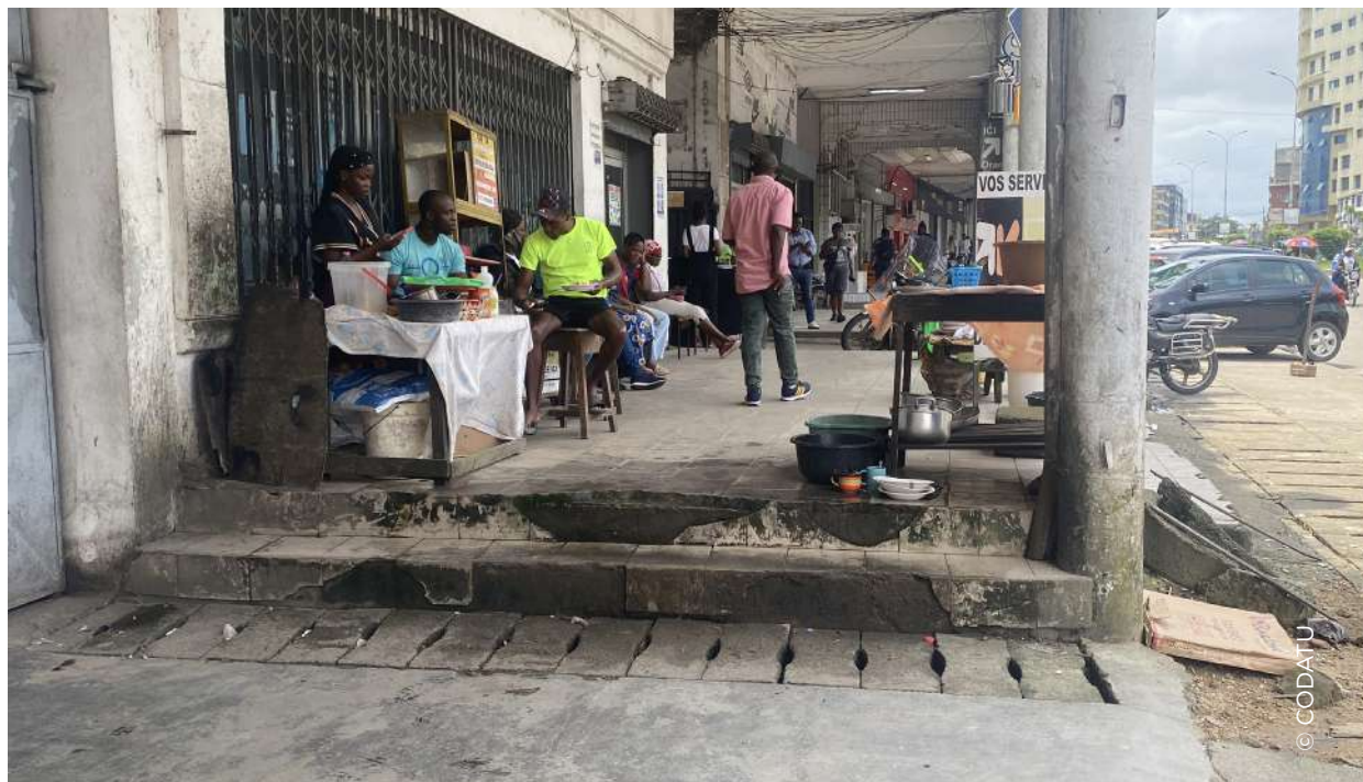
Image 25 : Discontinuité d'une galerie piétonne à Douala.
