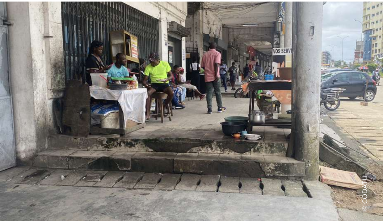
Image 25 : Discontinuité d'une galerie piétonne à Douala.
