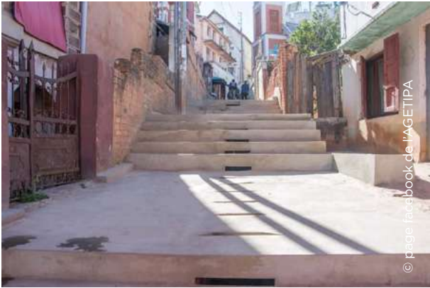
Image 34 : Aménagement d'un escalier.
