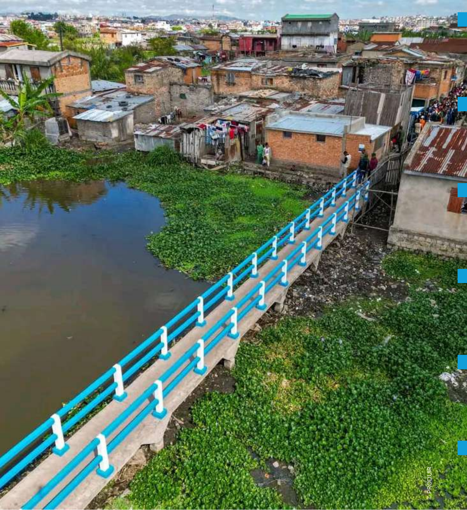
Image 35 : Aménagement de passerelle dans le cadre du projet PRODUIR.
