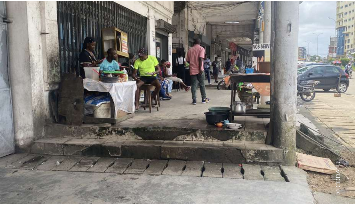
Image 25 : Discontinuité d'une galerie piétonne à Douala.
