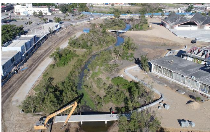
Figura 2: Río Chiveve y el proyecto de Infraestructura Urbana Verde en construcción.
