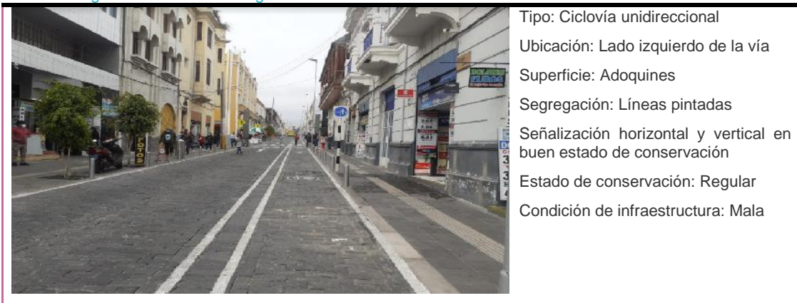
Figura 29. Evidencia fotográfica de la ciclovía de la Calle San Juan de Dios- Jerusalén
