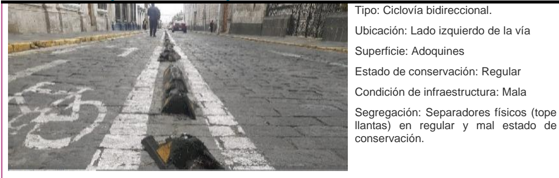
Figura 27. Evidencia fotográfica de la ciclovía de la Calle La Merced
