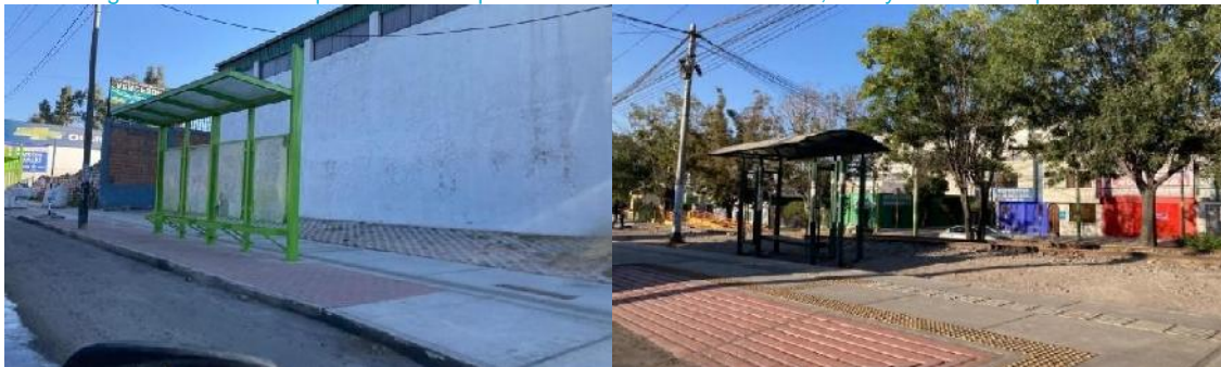
Figura 49. Corredor que se viene implementando en la Av. Aviación, incluye señalética piso táctil
