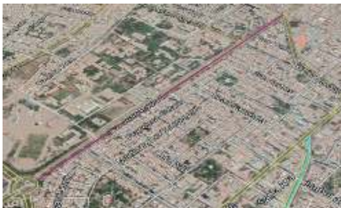
Av. Juan Pablo II tramo comprendido entre el Ovalo Papal (Av. América) y la Av. España (1.24 km.).
