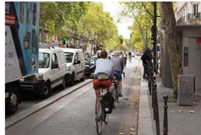
Le boulevard de Sébastopol (Paris), avant 2019 et depuis 2019. Une piste bidirectionnelle, tronçon du Réseau Express Vélo nord <-> sud, a remplacé une file de circulation générale. Elle permet d'emprunter l'axe à vélo dans les deux sens en étant séparé de la circulation, contrairement à la situation antérieure.
