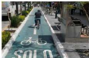
Los Mochis, México. Ciclovía unidireccional segregada, ubicada en el centro de la ciudad. Imagen: Instituto Municipal de Planeación de Ahome
