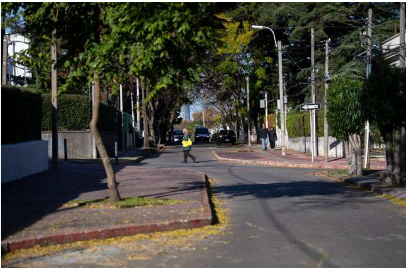
↑ Montevideo, Uruguay. Calles Carmelo y Vaz Ferreira, Prado: uso de chicanas como medida de tránsito calmado. Imagen: Diego Battiste.
